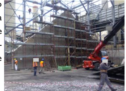
Realizzazione capannone coke
