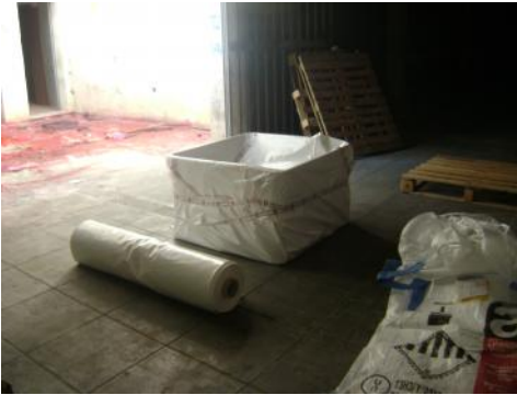
Rimozione serbatoi idrici
