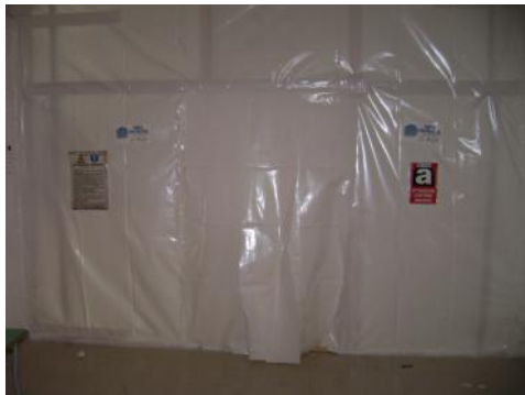
Confinamento per bonifica amianto
